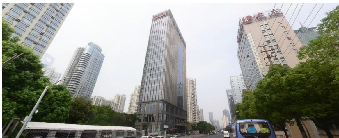
图一 项目西北侧
